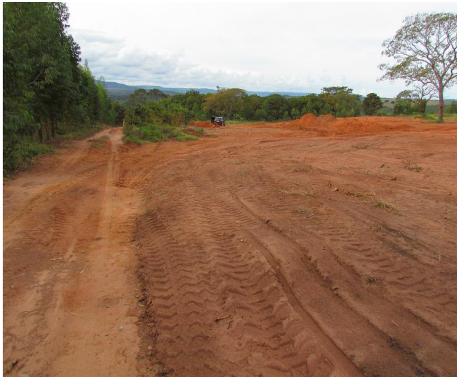
Foto 14. Área do aterro com valas encerradas e compactadas.
