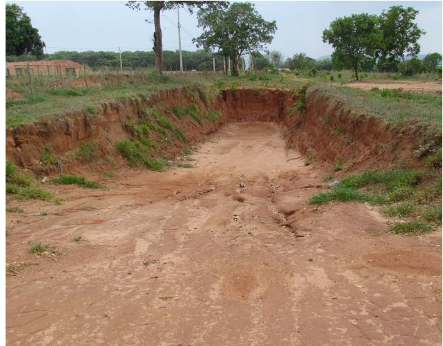
Foto 29. Vala aberta para depósito de resíduo inerte, do aterro já encerrado.
