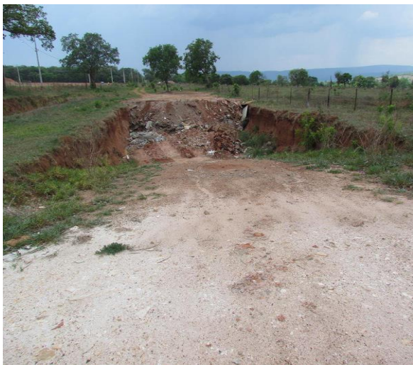
Foto 30. Vala para depósito dos resíduos inertes.
