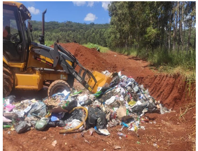
Foto 17. Máquina utilizada para movimentação de resíduos sólidos, onde, após a disposição dos resíduos sólidos, por meio de caminhões de coleta, é realizada a organização dos resíduos dentro da vala e posteriormente é feita a cobertura com terra.
